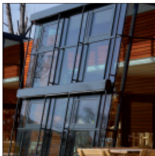
Wintergartenfassade Einfamilienhaus Salzburg
